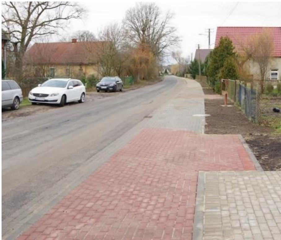
Fot. Chodnik w miejscowości Gronowice
