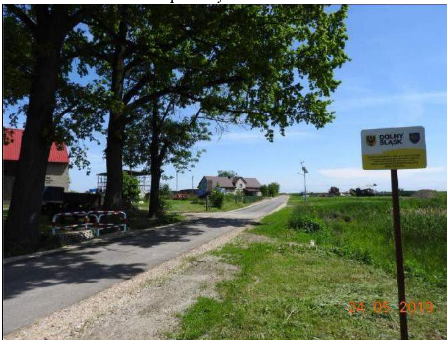
Fot. Droga dojazdowa do gruntów rolnych w miejscowości Radzowice.
