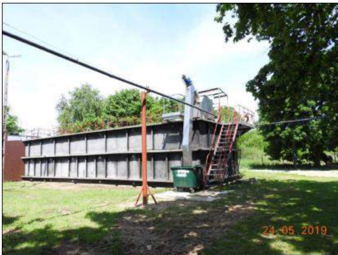
Fot. Oczyszczalnia ścieków w Dziadowej Kłodzie
