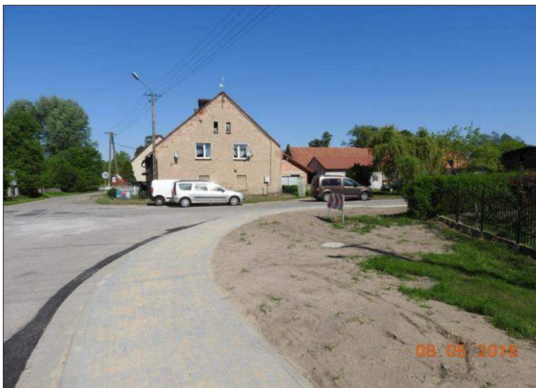
Fot. Chodnik przy drodze powiatowej w miejscowości Gronowice
