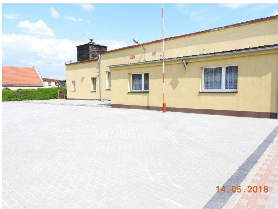
Fot. Plac przy świetlicy wiejskiej w miejscowości Miłowice- utwardzenie działki kostką brukową
