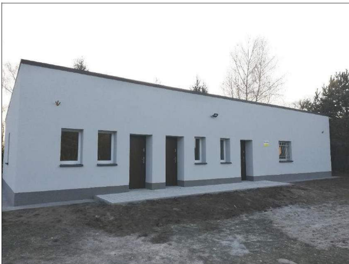
Fot. Budynek szatni sportowej, Dziadowa Kłoda
